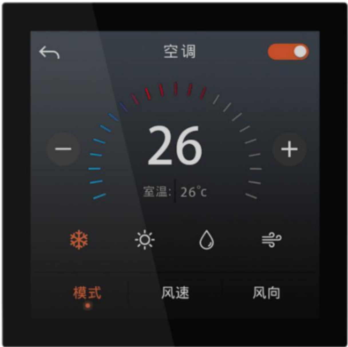
中央空调控制
